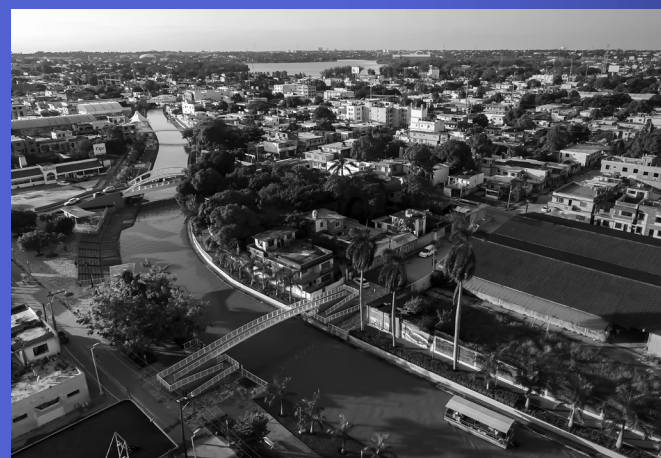
Canal de la Cortadura, Tampico, Tamaulipas. Fotografías: cortesía GPU.
