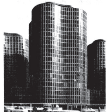
1966. Edificios Trade. Barcelona.
