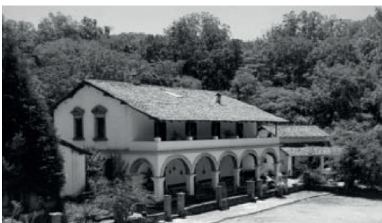
Figura 25. Vivienda aislada antigua.
