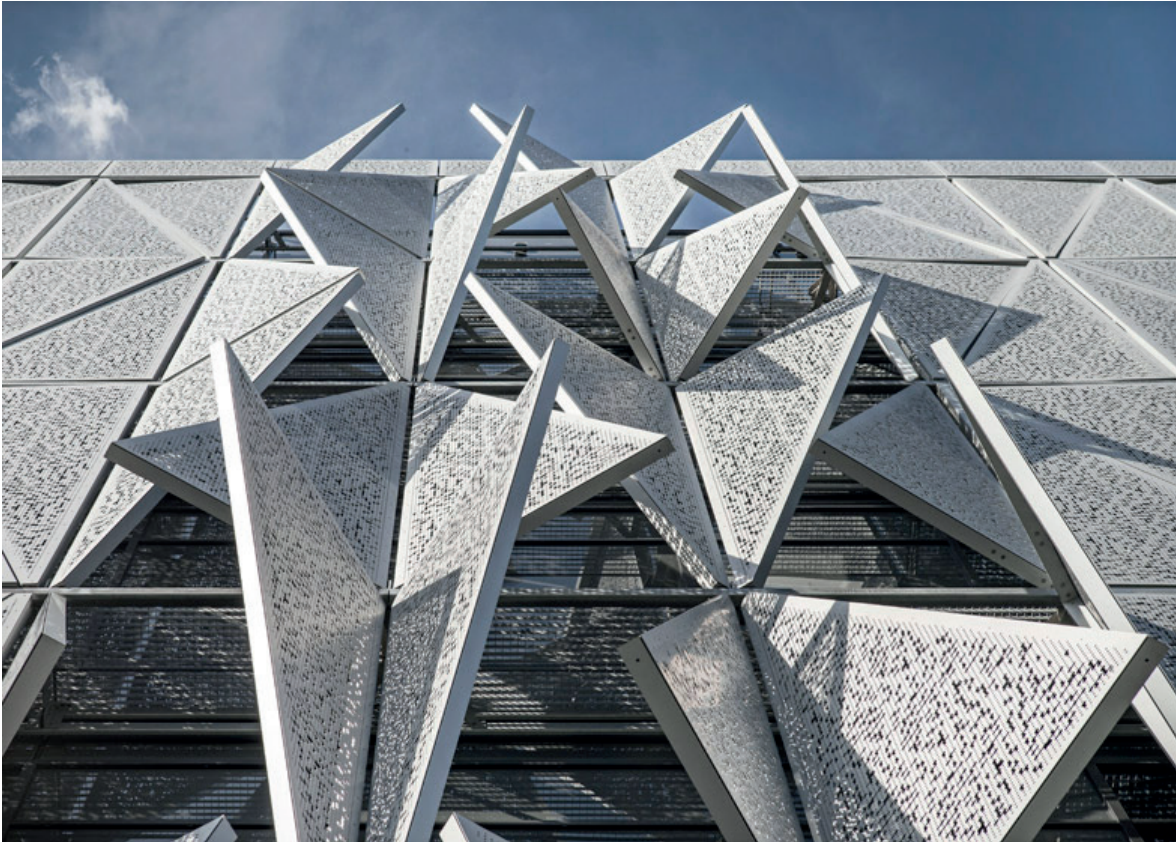
Figura 7. Fachada Inteligente.-Extraído el 26 de abril 2021. Fuente extraída de: https://www.paredro.com/universidad-de-dinamarca-cuenta-con-una-fachada-inteligente/
