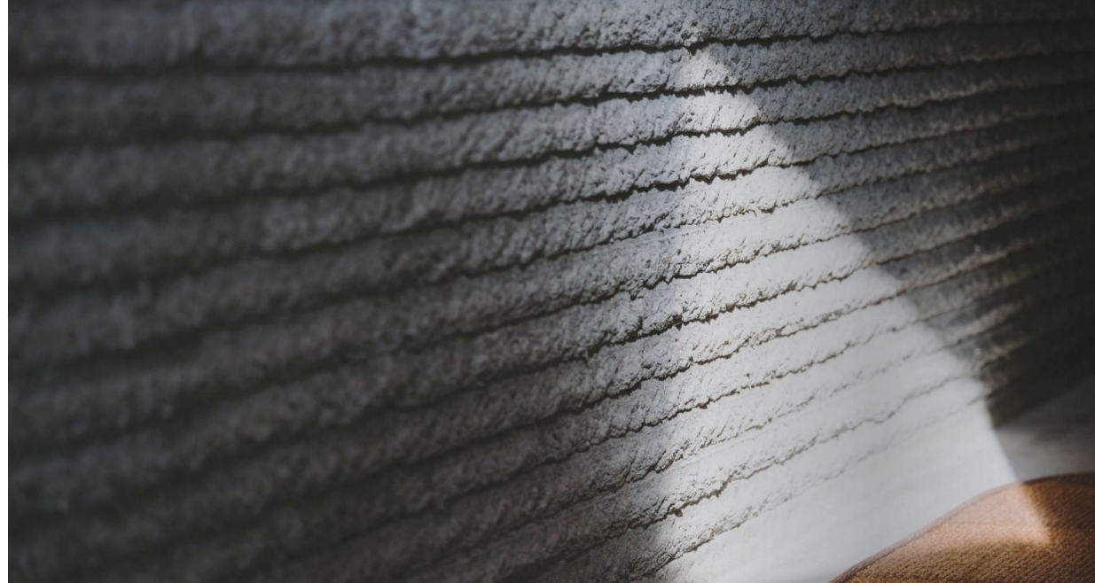
Concreto en capas.
