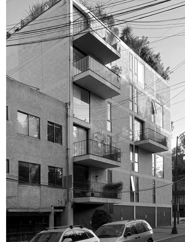
Edificio habitacional en la Avenida Alfonso Reyes núm. 200, colonia La Condesa, Ciudad de México. Fotografía: Jorge Javier, diciembre de 2021.
