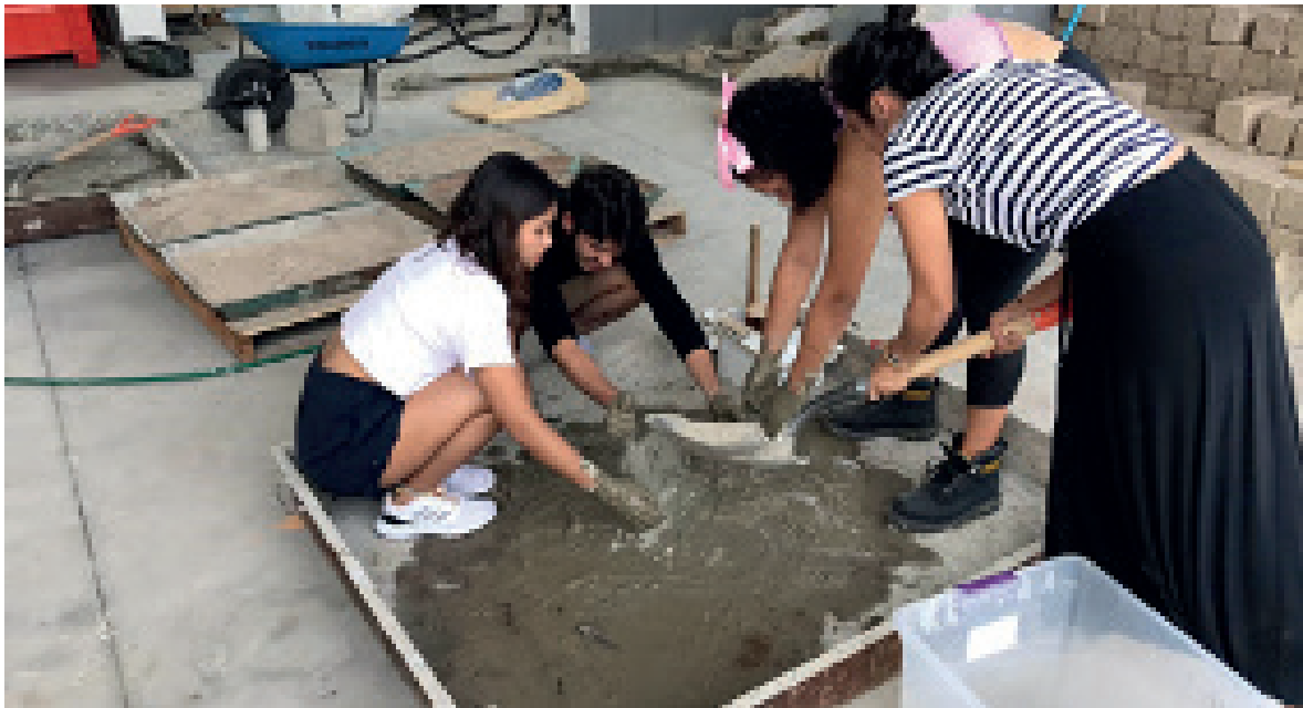
Figura 4. Colado de cubos de concreto para taller vertical de maquetas experimentales.
