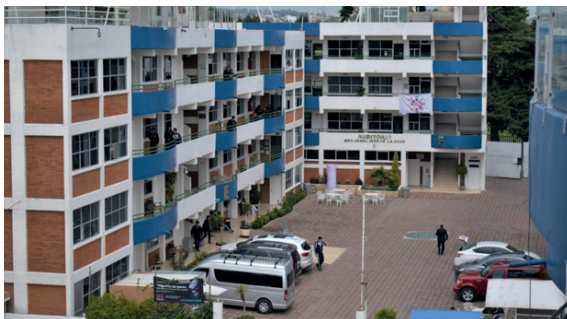
Fotografía 3. Diseño de cafeterías y cubiertas de lonarías en azoteas de edificios de aulas
