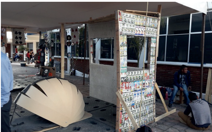
Fotografía 5. Paneles hechos con materiales reciclados (madera, tetrapaks, alambre) para refugios temporales, y capsula para dormir hecha con reciclaje de triplay elaborados por alumnos de los primeros semestres de Arquitectura.
