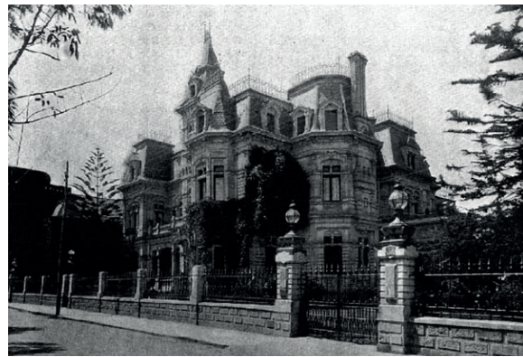
Ilustración 2. Casa de la Sra. Braniff, finales del siglo XIX. Los jardines aislaban a las casas de la calle. Fuente: Genaro García, Crónica oficial de las fiestas del primer centenario de la Independencia de México
