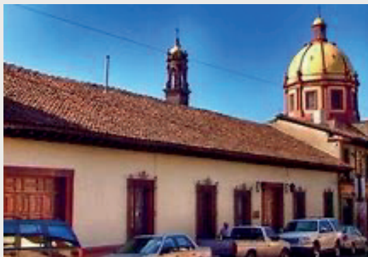
Ilustración 5. Casa natal de General Lázaro Cárdenas de Río, (Fachada principal), primera mitad del siglo XX.
