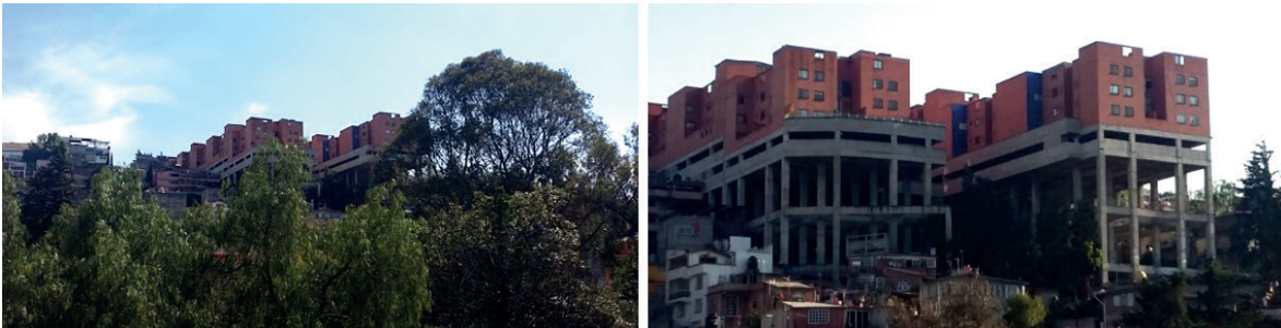
Figura 4. Edificios sobre una barranca en Ciudad de México. Fotos de la autora.
