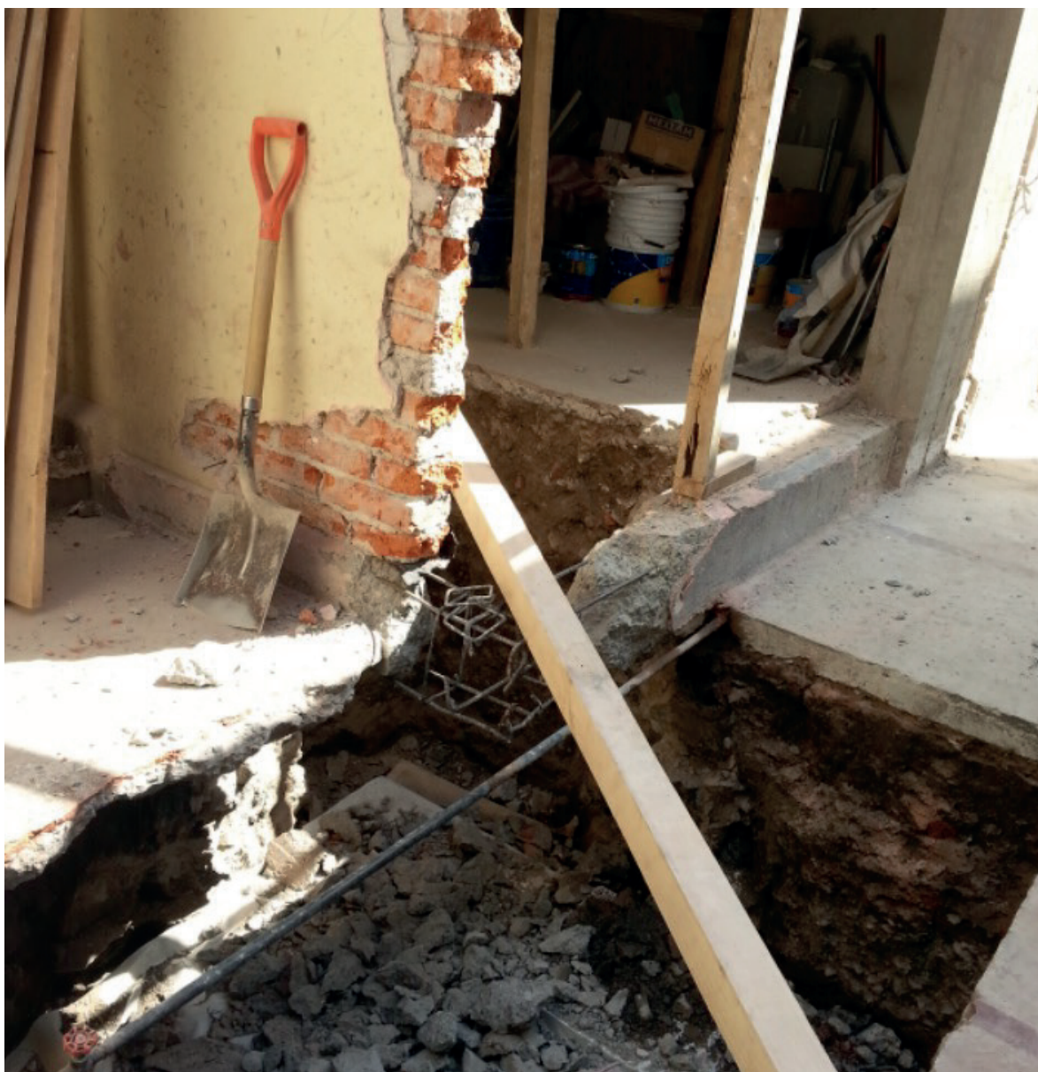
Figura 1. Visita de un edificio en la Colonia Condesa con alumnos durante la etapa de recuperación después del sismo de 2017. Fuente: Fotografía tomada por Daniel Ochoa.
