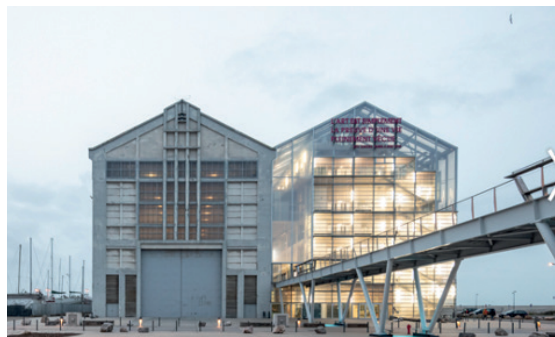
Imagen 2. Centro cultural, FRAC Nord-Pas de Calais, Dunkerque. Arquitectos Lacaton y Vassal -premio Pritzker 2021-, optaron por mantener la sala original y adjuntar la segunda al edificio existente, su concepto básico es "nunca demoler". Fotografía: Philippe Ruault. https://obras.expansion.mx/arquitectura/2021/03/16/lacaton-vassal-son-el-premio-pritzker-2021 .
