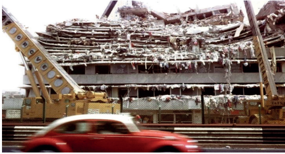
Imagen 3. Destrucción Edificio Costureras Calz. San Antonio Abad (Calz. De Tlalpan) Ciudad de México (Terremoto del 19 de septiembre de 1985). Fuente: colección Colectivo 19-S.
