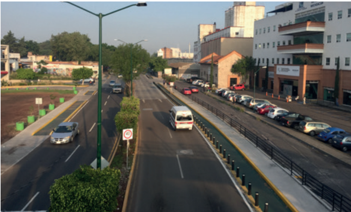
Figura 3. Panorámica de la Avenida Héroes de Nocupétaro, en Morelia, Mich., vista al poniente.
