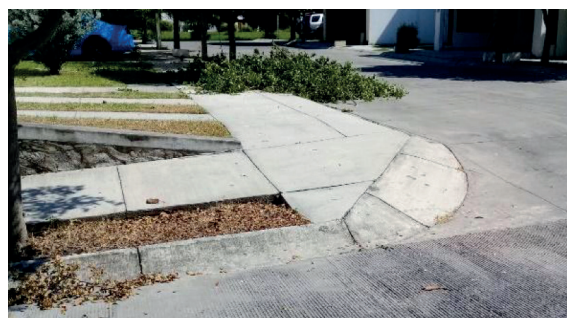
Figura 9. Fotografía de una rampa para silla de ruedas en la esquina de una de las vialidades dentro del fraccionamiento. Fuente: Archivo del autor.
