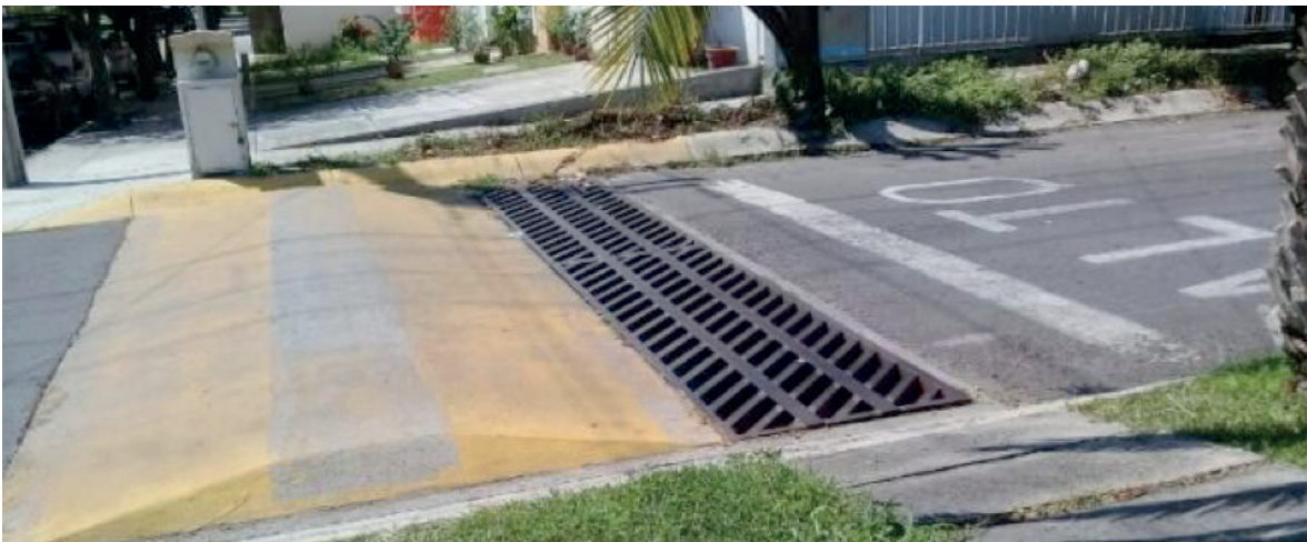
Figura 7. Rejilla de captación de agua pluvial ubicada en el cruce de la Av. Volcanes con Paseo de los cipreses. Fuente: Archivo del autor.
