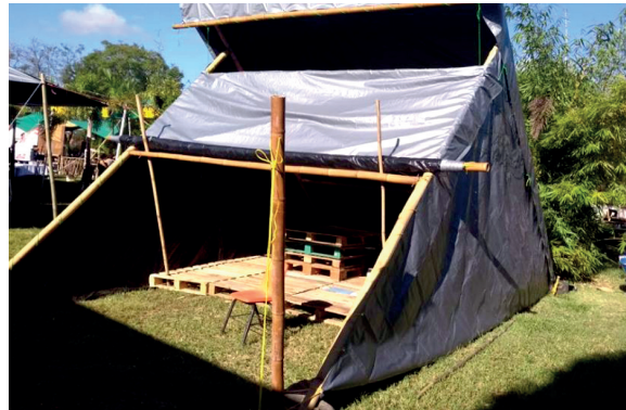
Figura No.6. Prototipo de vivienda emergente construida por voluntarios en el programa 8.2. Fuente: https://www.facebook.com/mexicoochodos/photos/
