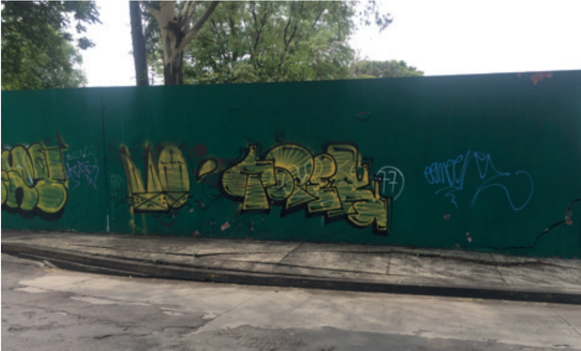
Figura 5. Aspecto general de las afectaciones por falla geológica en elemento perimetral de instalaciones del IMSS después de la demolición de la torre del Hospital General Regional Núm. 1. Fuente: Archivo propio.
